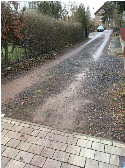
WIDOK NA ISTNIEJĄCY DOJAZD OD STRONY ISTNIEJĄCYCH UTWARDZEŃ PRZY BUDYNKU NR 24D
