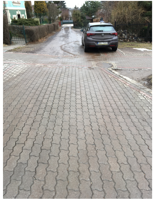
WIDOK NA ISTNIEJĄCY DOJAZD OD STRONY WJAZDU – UL. KOLEJOWA
