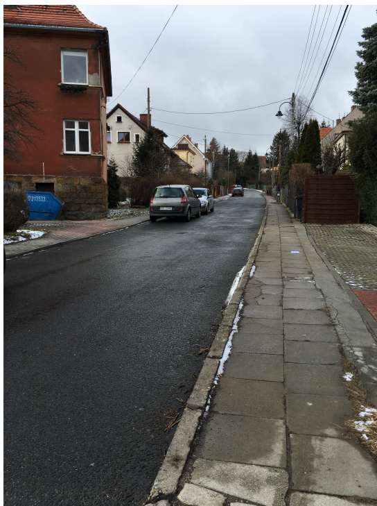
WIDOK NA ISTNIEJĄCY CHODNIK OD STRONY SKRZYŻOWANIA Z ULICĄ B. PRUSA
