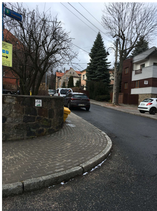
WIDOK NA ISTNIEJĄCY CHODNIK LEWOSTRONNY OD STRONY SKRZYŻOWANIA Z UL. B.PRUSA
