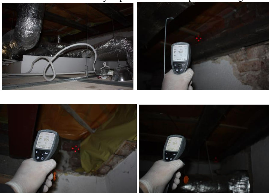
Fot. 4. Pomiary w przestrzeni sufitu podwieszanego
