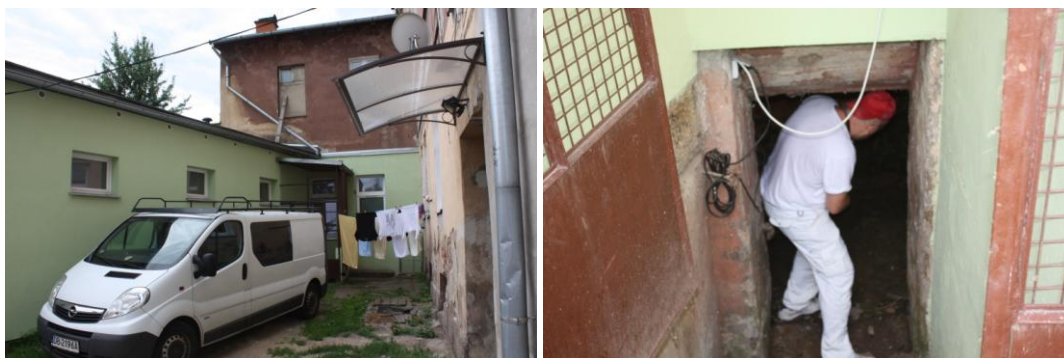
Wejście do piwnicy znajdującej się pod częścią gospodarczo- socjalną
