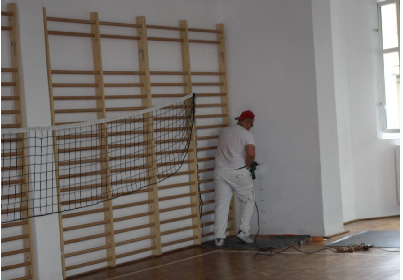
Wykonanie otworów pomiarowych
