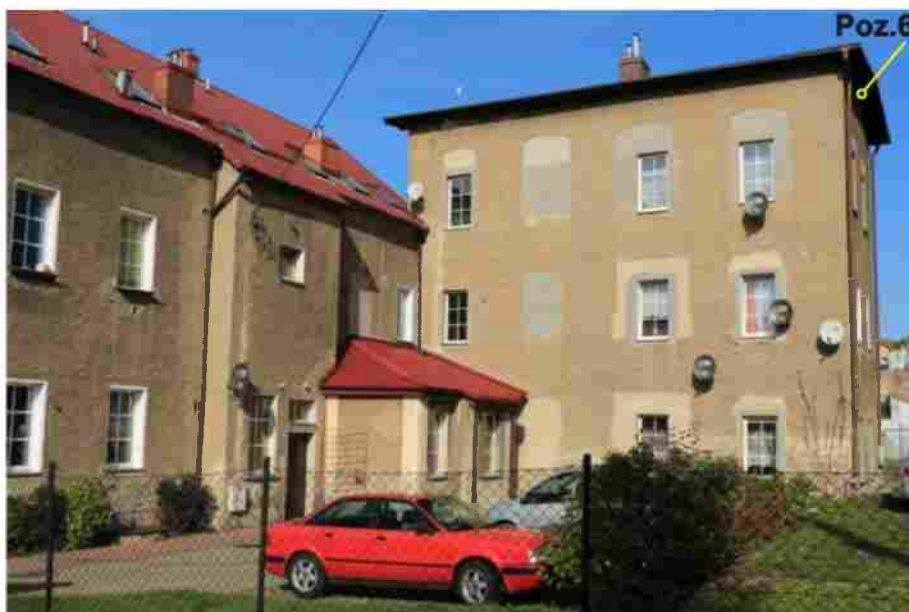
Ryc. 13. Budynek przy ul. Równoległej 16 – ściany wschodnie i południowe - z zaznaczeniem pozycji stwierdzonych gniazd i siedlisk.
