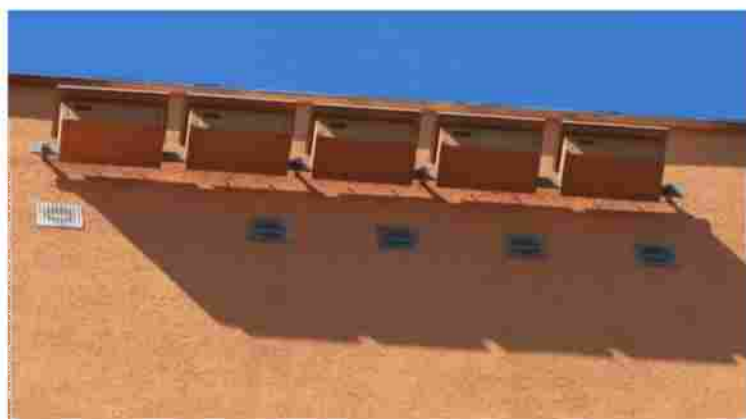
Ryc. 32. Przykładowy sposób zamocowania pięciu budek dla jerzyka typu APK-1 do budynku – za pomocą płaskownika i czterech kotew mocujących płaskownik do ściany budynku, przechodzących przez warstwę termoizolacyjną.
