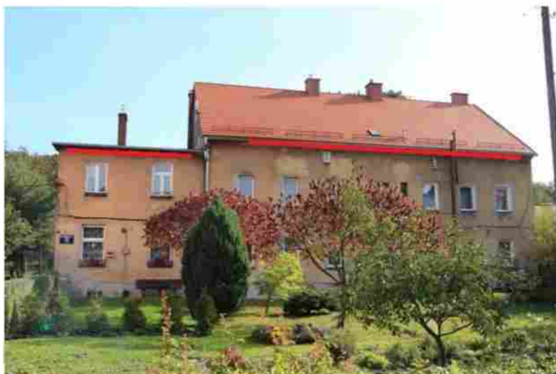
Ryc 22. Potencjalne siedliska nietoperzy w budynku przy ul. Równoległej 11 cz3
