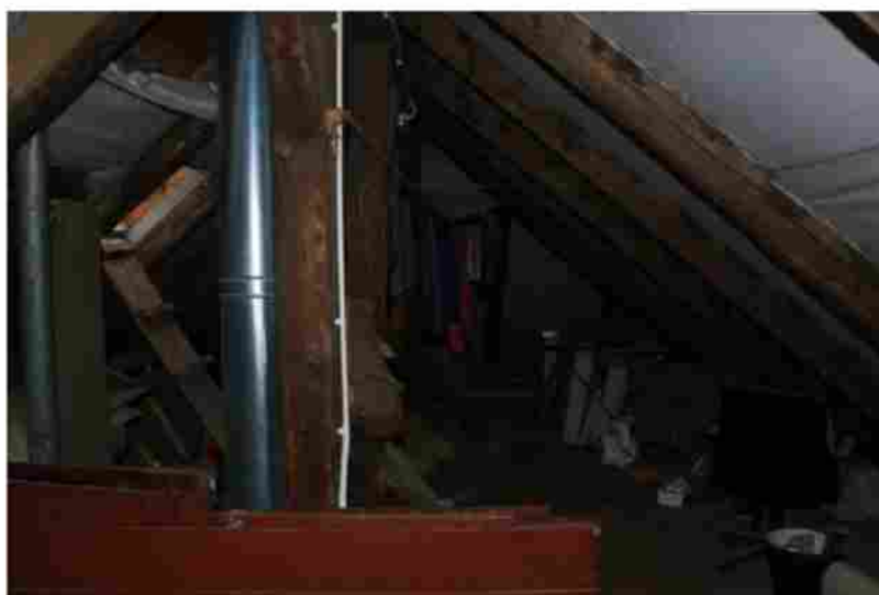
Ryc 9. Użytkowane poddasze w budynku przy ul. Okrężnej 3
