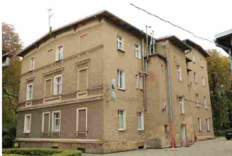
Ryc 1. Budynek przy ul. Kolejowej 15– przedmiot analizy
