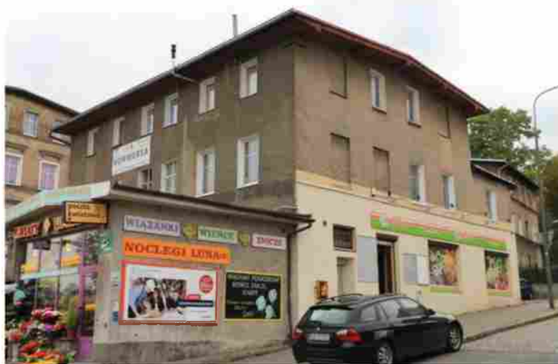
Ryc 8. Budynek przy ul. Solickiej 2– przedmiot analizy
