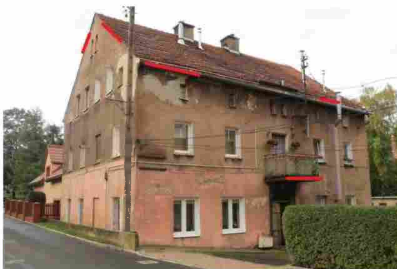
Ryc 24. Potencjalne siedliska nietoperzy w budynku przy ul. Równoległej 12 cz2
