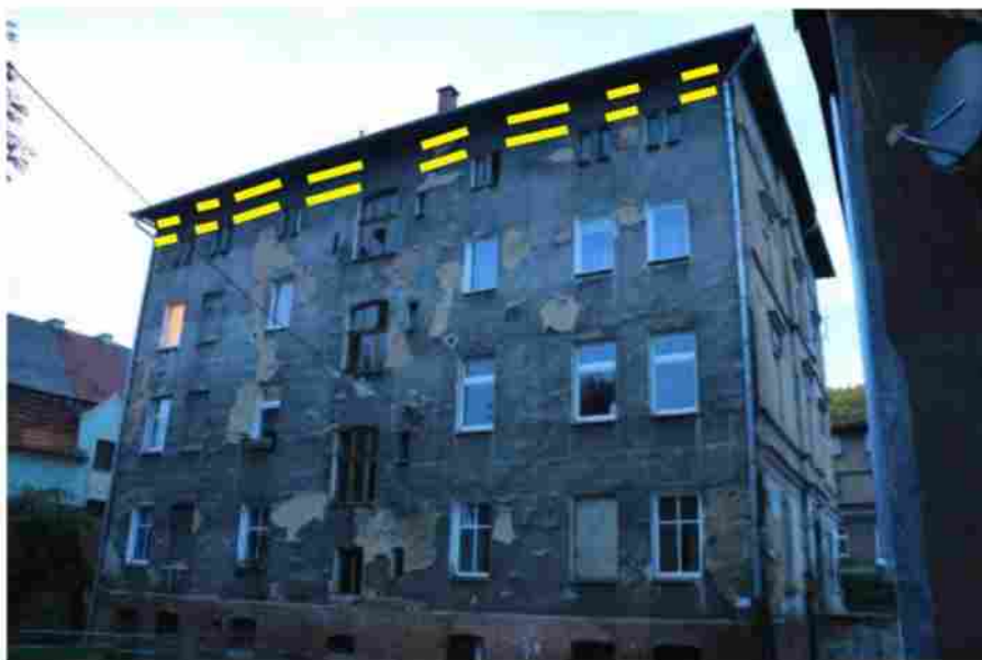
Ryc. 31. Budynek przy ul. Sienkiewicza 41 - ściana wschodnia - z zaznaczeniem miejsca realizacji kompensacji. Żółta linia oznacza miejsce zawieszenia budek trocinobetonowych typu APK-1 lub APK-2 w jednym rzędzie.
