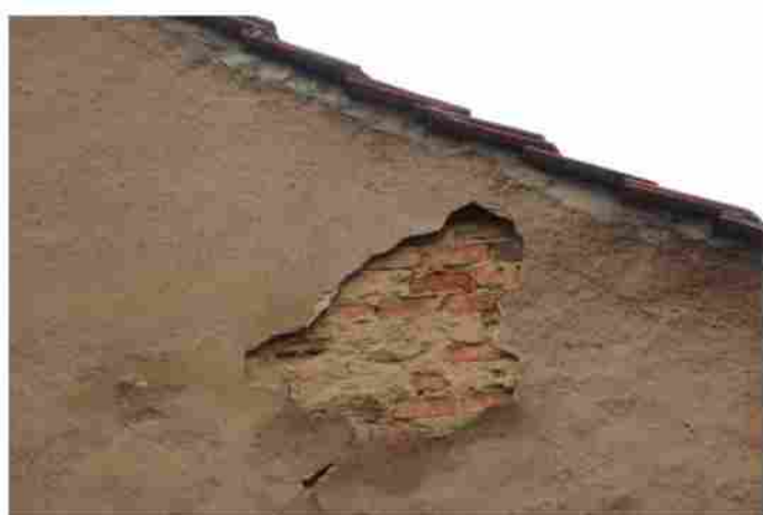
Ryc. 11. Budynek przy ul. Równoległej 12 – widoczne uszczelnienia wykonane wraz z przełożeniem dachu.
