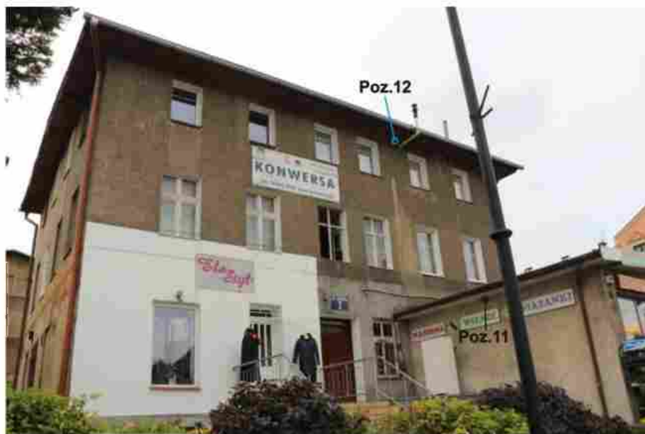
Ryc. 16. Budynek przy ul. Solickiej 2 – ściana zachodnia - z zaznaczeniem pozycji stwierdzonych gniazd i siedlisk.
