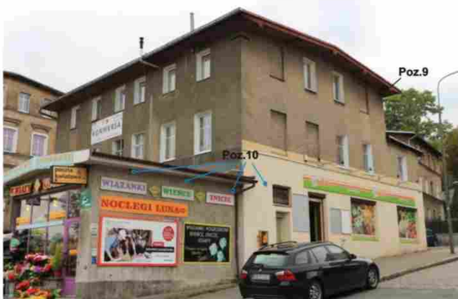
Ryc. 14. Budynek przy ul. Solickiej 2 – ściana północna i wschodnia - z zaznaczeniem pozycji stwierdzonych gniazd i siedlisk.
