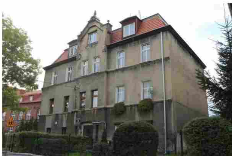
Ryc 6. Budynek przy ul. Sienkiewicza 34 – przedmiot analizy
