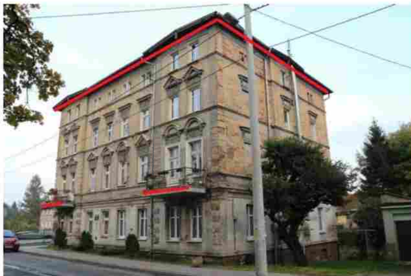
Ryc 33. Potencjalne siedliska nietoperzy w budynku przy Sienkiewicza 41a cz2
