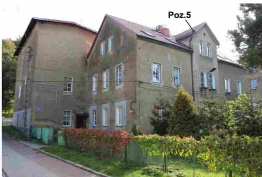
Ryc. 12. Budynek przy ul. Równoległej 16 – ściany zachodnie i północne - z zaznaczeniem pozycji stwierdzonych gniazd i siedlisk.
