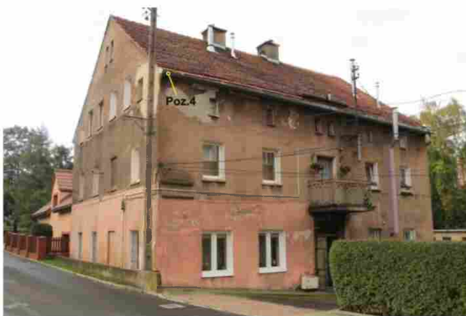
Ryc. 9. Budynek przy ul. Równoległej 12 – elewacja północna i ściana wschodnia – z zaznaczeniem pozycji stwierdzonych gniazd i siedlisk.
