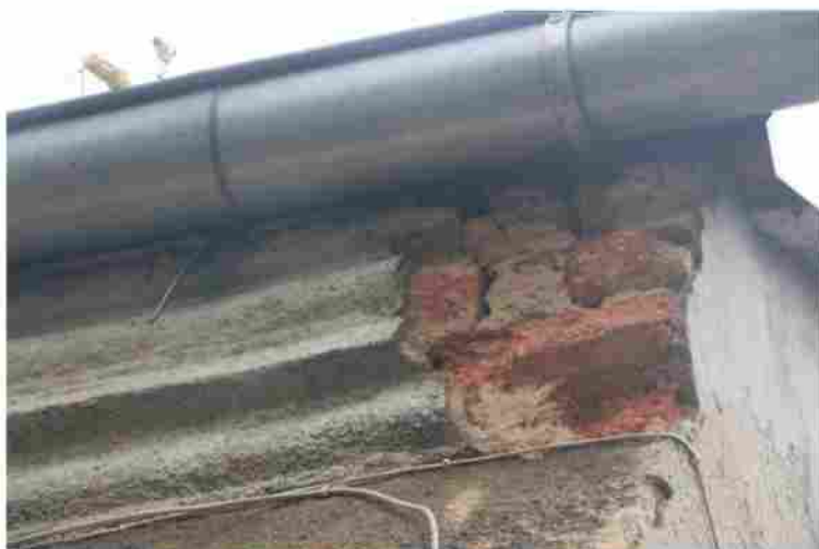
Ryc. 3. Budynek przy ul. Okrężnej 3, widok na potencjalne miejsca lęgowe ptaków w szczelinach za rynną.
