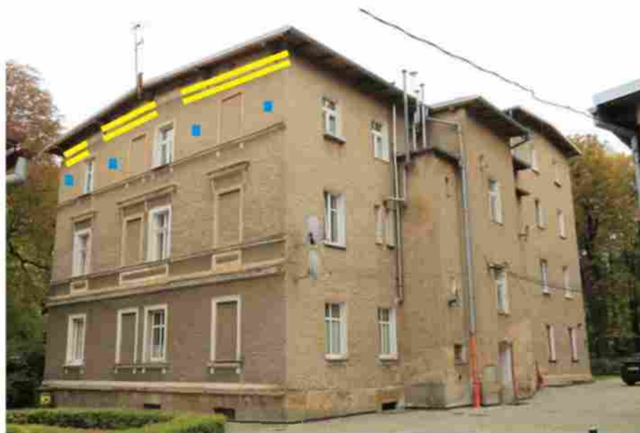
Ryc. 28. Budynek przy ul. Kolejowej 15 - ściana wschodnia i północna - z zaznaczeniem miejsc realizacji kompensacji. Żółta linia oznacza miejsce zawieszenia rzędu budek trocinobetonowych dla jerzyka (typ APK-2). Niebieskie prostokąt – miejsce zawieszenia budki trocinobetonowej dla kawki.
