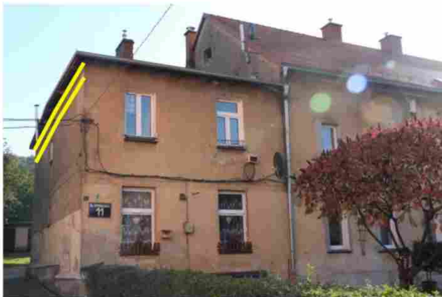
Ryc. 24. Miejsca zawieszenia budek dla jerzyków na elewacji północnej budynku przy ul. Równoległej 11. Każda żółta linia oznacza kilkanaście budek dla jerzyka typu APK-1 w jednym rzędzie.
