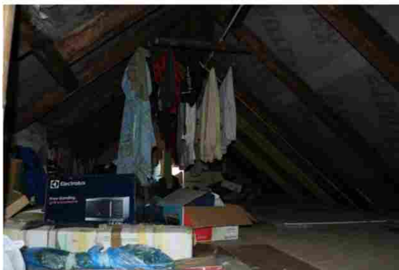
Ryc 10. Użytkowane poddasze w budynku przy ul. Równoległej 16
