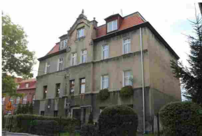
Ryc 6. Budynek przy ul. Sienkiewicza 34 – przedmiot analizy
