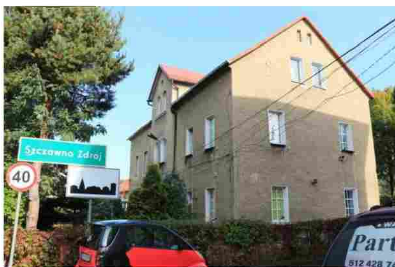
Ryc 5. Budynek przy ul. Równoległej 16 – przedmiot analizy
