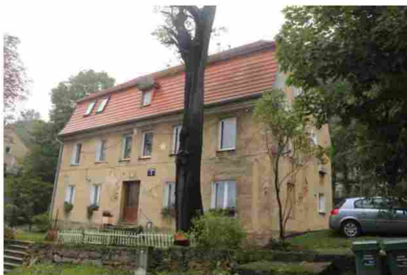
Ryc 2. Budynek przy ul. Okrężnej 3 – przedmiot analizy
