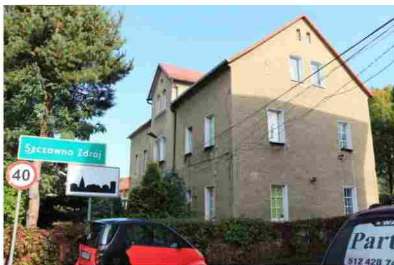
Ryc 5. Budynek przy ul. Równoległej 16 – przedmiot analizy
