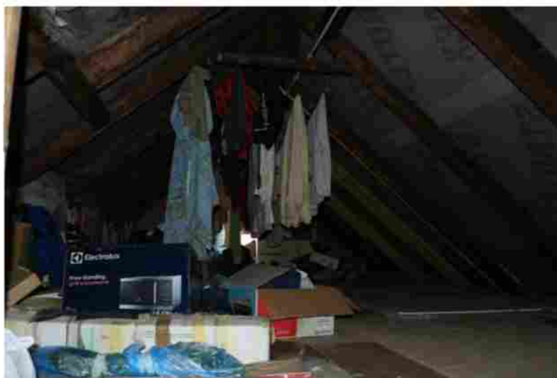
Ryc 10. Użytkowane poddasze w budynku przy ul. Równoległej 16
