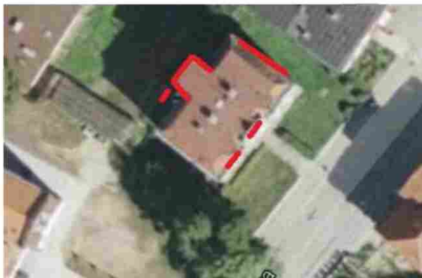
Ryc 29. Potencjalne siedliska nietoperzy w budynku przy ul. Sienkiewicza 34 cz1
