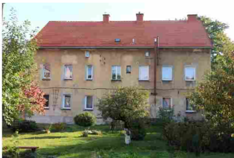
Ryc 3. Budynek przy ul. Równoległej 11 – przedmiot analizy
