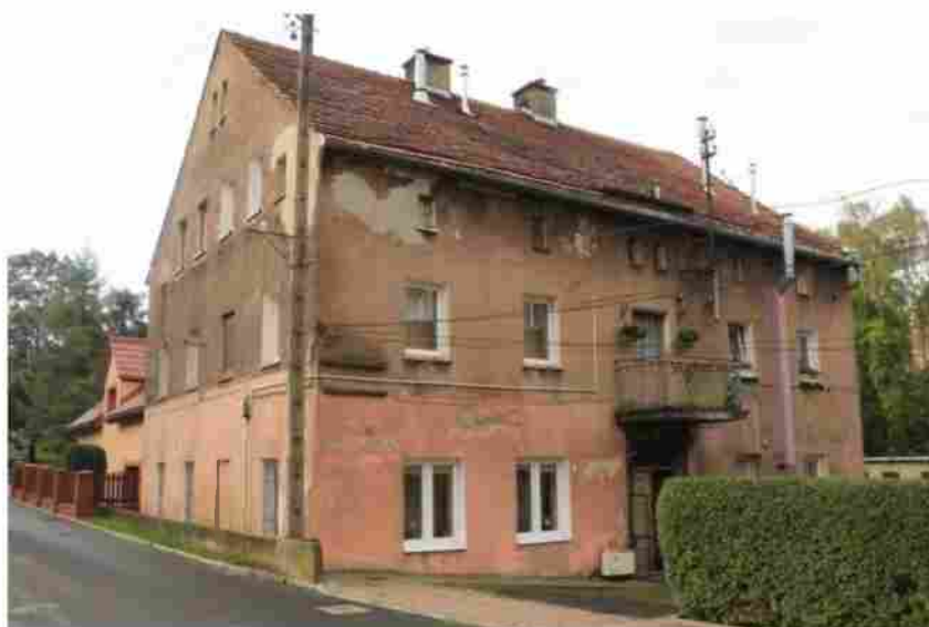
Ryc 4. Budynek przy ul. Równoległej 12 – przedmiot analizy
