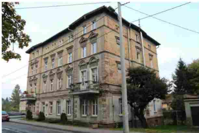
Ryc 7. Budynek przy ul. Sienkiewicza 41a – przedmiot analizy
