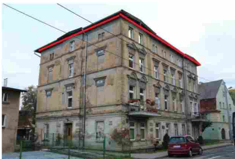
Ryc 34. Potencjalne siedliska nietoperzy w budynku przy ul. Sienkiewicza 41a cz3
