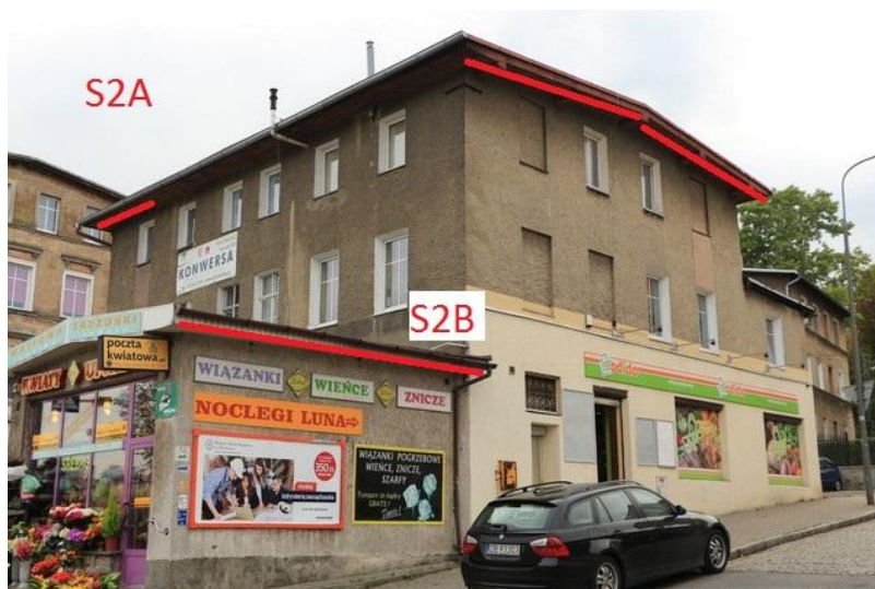
Ryc 37. Potencjalne siedliska nietoperzy w budynku przy ul. Solickiej 2 cz3
