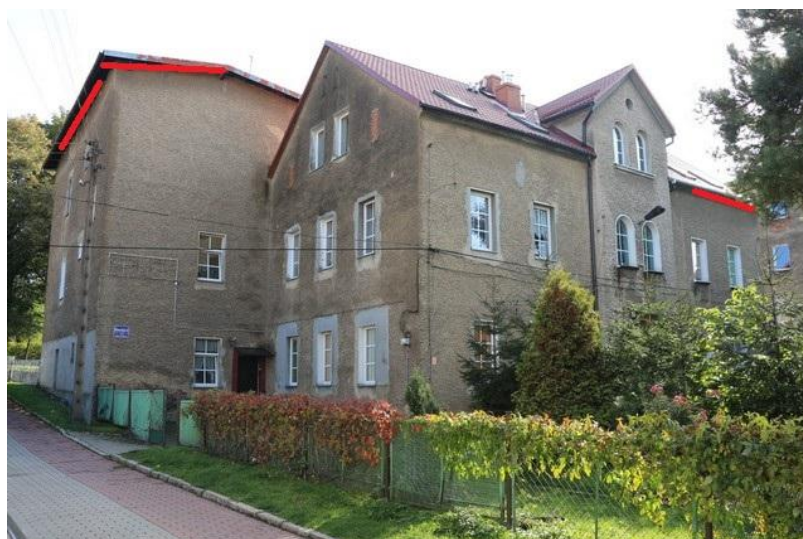
Ryc 28. Potencjalne siedliska nietoperzy w budynku przy ul. Równoległej 16 cz3
