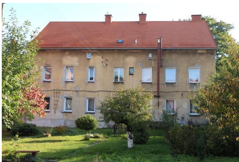
Ryc 3. Budynek przy ul. Równoległej 11 – przedmiot analizy
