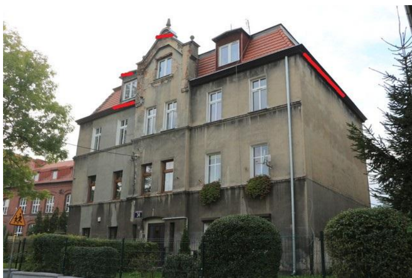
Ryc 31. Potencjalne siedliska nietoperzy w budynku przy ul. Sienkiewicza 34 cz3
