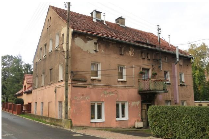
Ryc 4. Budynek przy ul. Równoległej 12 – przedmiot analizy
