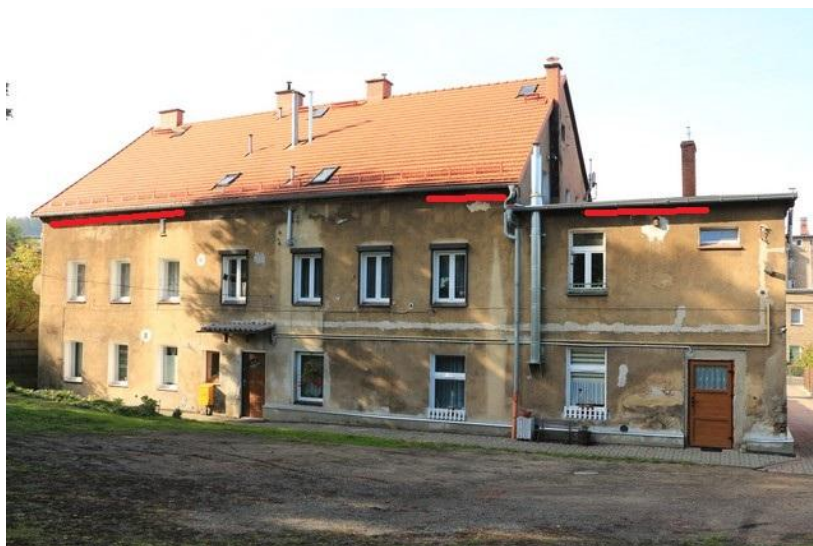
Ryc 21. Potencjalne siedliska nietoperzy w budynku przy ul. Równoległej 11 cz2
