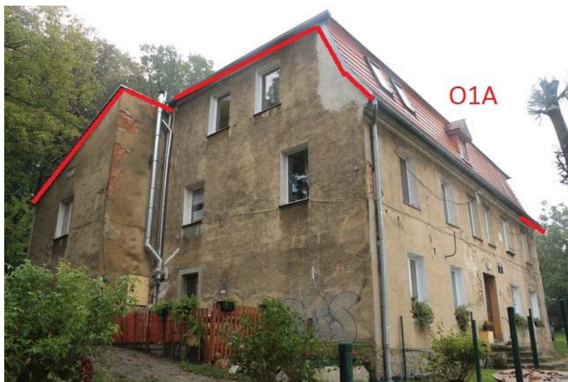
Ryc 18. Potencjalne siedliska nietoperzy w budynku przy ul. Okężnej 3 cz2
