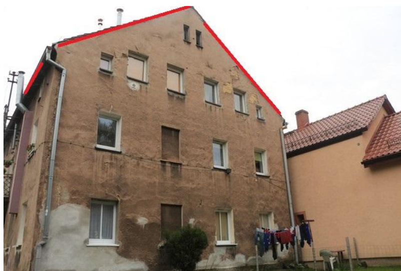
Ryc 25. Potencjalne siedliska nietoperzy w budynku przy ul. Równoległej 12 cz3
