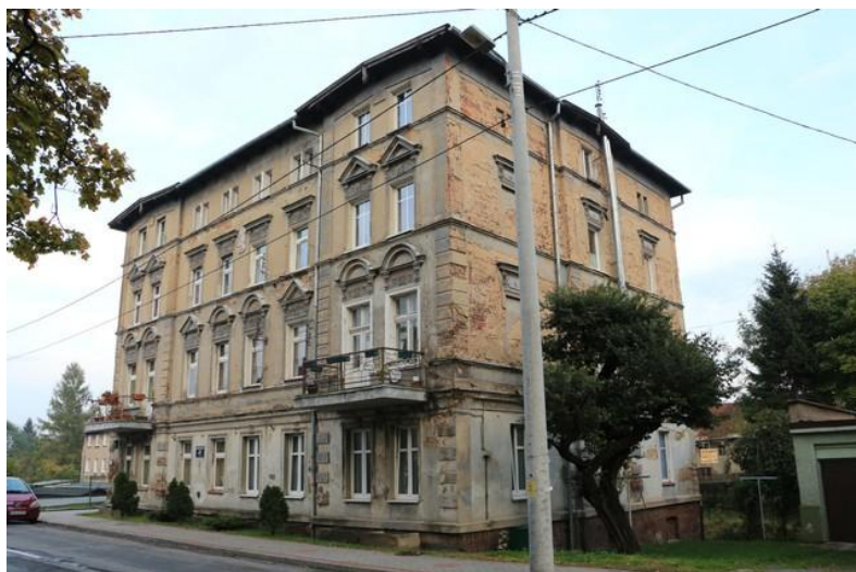
Ryc 7. Budynek przy ul. Sienkiewicza 41a – przedmiot analizy
