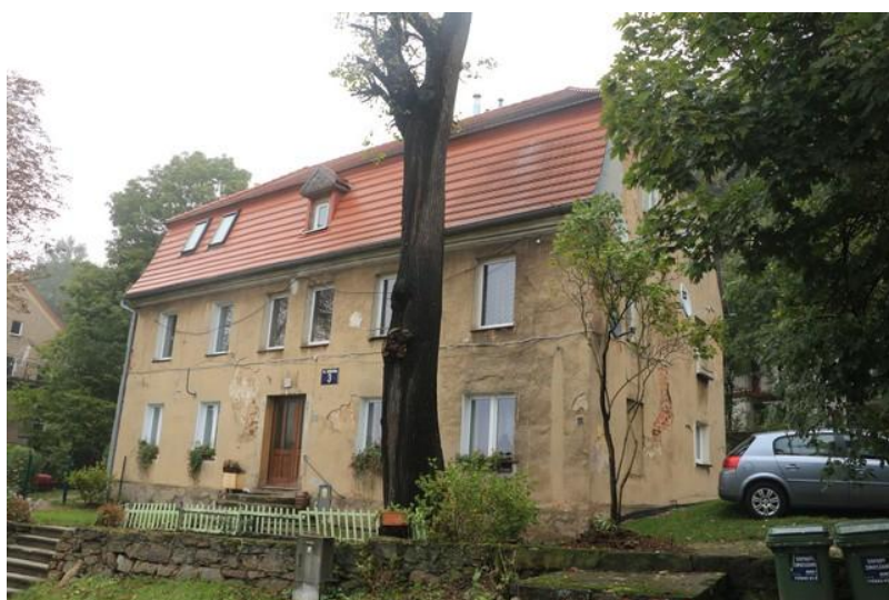
Ryc 2. Budynek przy ul. Okrężnej 3 – przedmiot analizy
