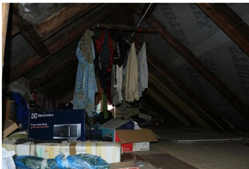
Ryc 10. Użytkowane poddasze w budynku przy ul. Równoległej 16
