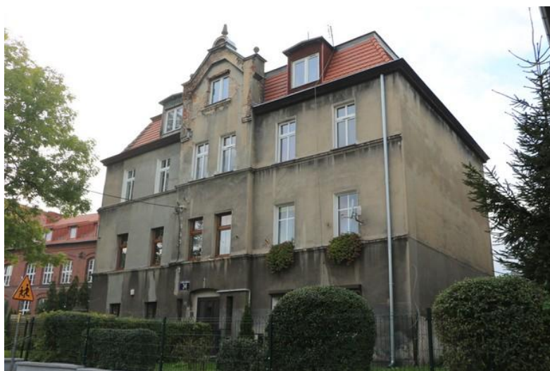
Ryc 6. Budynek przy ul. Sienkiewicza 34 – przedmiot analizy
