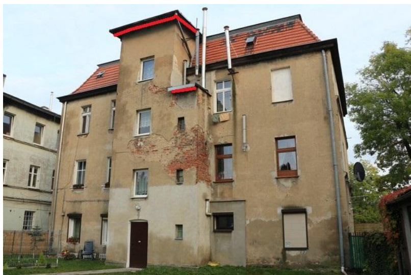
Ryc 30. Potencjalne siedliska nietoperzy w budynku przy ul. Sienkiewicza 34 cz2
