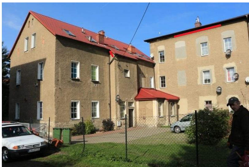
Ryc 27. Potencjalne siedliska nietoperzy w budynku przy ul. Równoległej 16 cz2
