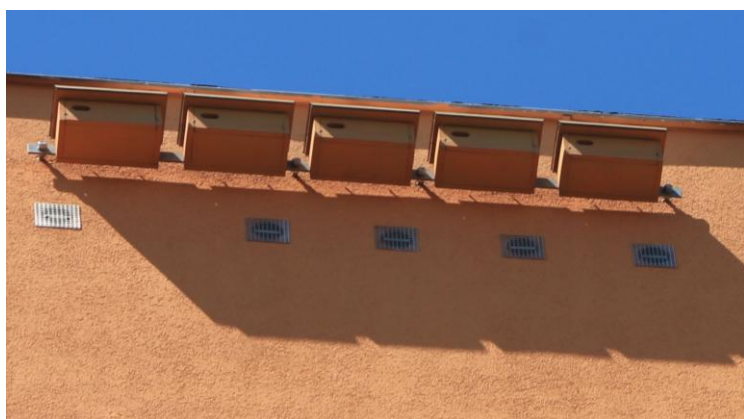
Ryc. 32. Przykładowy sposób zamocowania pięciu budek dla jerzyka typu APK-1 do budynku – za pomocą płaskownika i czterech kotew mocujących płaskownik do ściany budynku, przechodzących przez warstwę termoizolacyjną.
