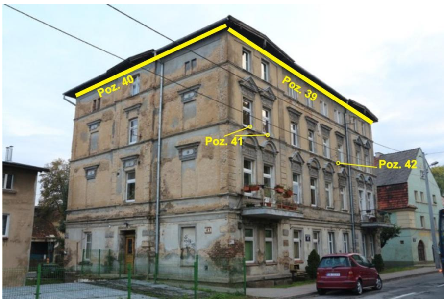
Ryc. 19. Budynek przy ul. Sienkiewicza 41 – elewacja zachodnia i północna – z zaznaczeniem pozycji stwierdzonych gniazd i siedlisk.
