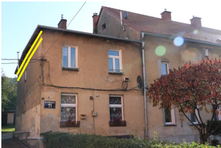
Ryc. 24. Miejsca zawieszenia budek dla jerzyków na elewacji północnej budynku przy ul. Równoległej 11. Każda żółta linia oznacza kilkanaście budek dla jerzyka typu APK-1 w jednym rzędzie.
