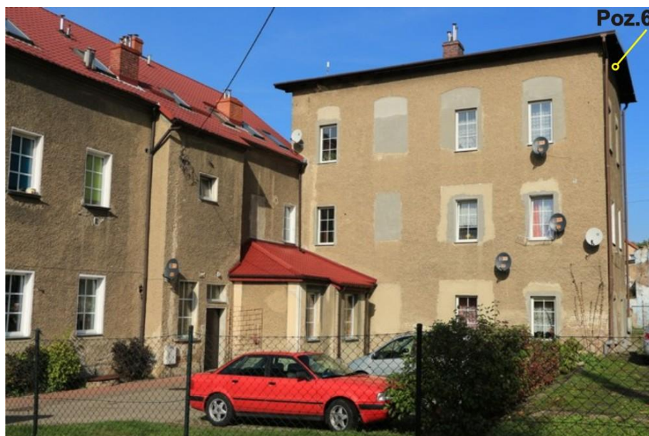
Ryc. 13. Budynek przy ul. Równoległej 16 – ściany wschodnie i południowe - z zaznaczeniem pozycji stwierdzonych gniazd i siedlisk.
