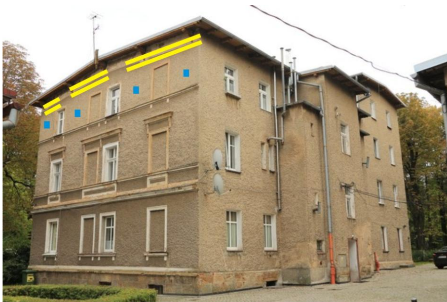
Ryc. 28. Budynek przy ul. Kolejowej 15 - ściana wschodnia i północna - z zaznaczeniem miejsc realizacji kompensacji. Żółta linia oznacza miejsce zawieszenia rzędu budek trocinobetonowych dla jerzyka (typ APK-2). Niebieskie prostokąt – miejsce zawieszenia budki trocinobetonowej dla kawki.
