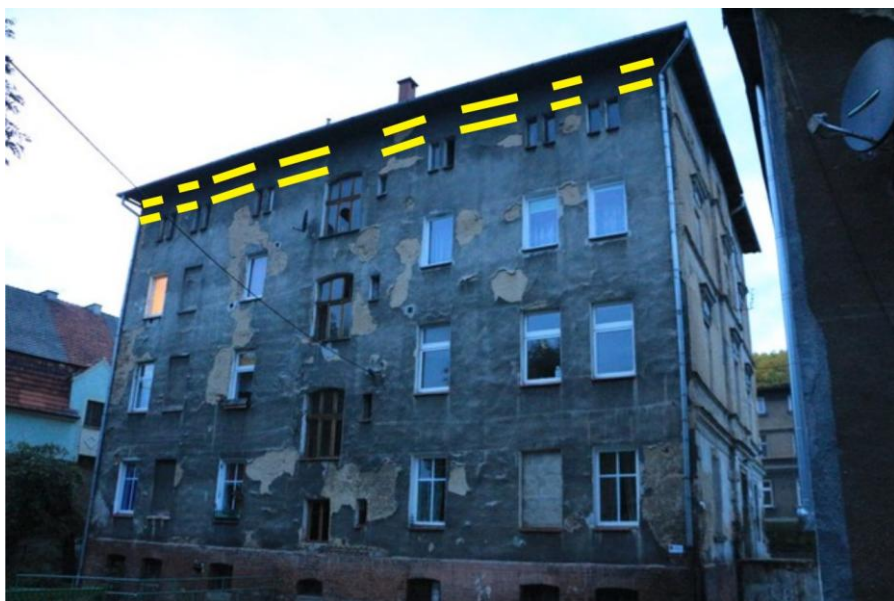
Ryc. 31. Budynek przy ul. Sienkiewicza 41 - ściana wschodnia - z zaznaczeniem miejsca realizacji kompensacji. Żółta linia oznacza miejsce zawieszenia budek trocinobetonowych typu APK-1 lub APK-2 w jednym rzędzie.
