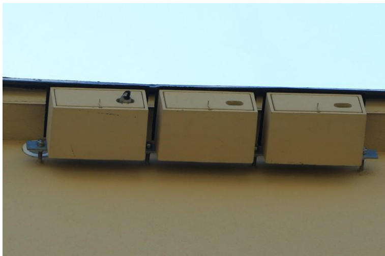
Ryc. 33. Trzy budki typu APK-1 przymocowane do budynku za pomocą płaskownika i czterech kotew; jedna z nich zajęta przez wróbla.
