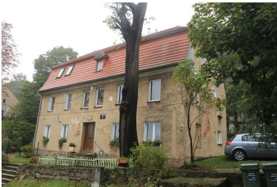
Ryc. 1. Budynek przy ul. Okrężnej 3 – elewacja wejściowa (zachodnia) oraz ściana południowa.
