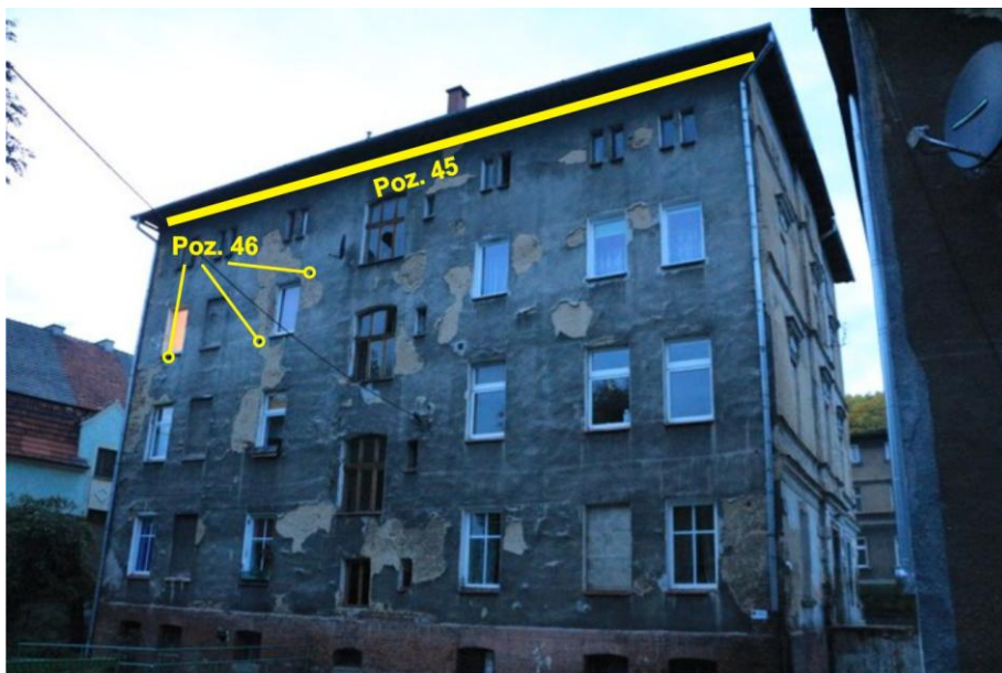
Ryc. 21. Budynek przy ul. Sienkiewicza 41 – elewacja wschodnia – z zaznaczeniem pozycji stwierdzonych gniazd i siedlisk.
