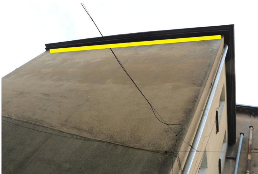
Ryc. 29. Budynek przy ul. Sienkiewicza 34 - ściana północno-wschodnia - z zaznaczeniem miejsca realizacji kompensacji. Żółta linia oznacza miejsce zawieszenia rzędu budek trocinobetonowych dla jerzyka (typ APK-2).
