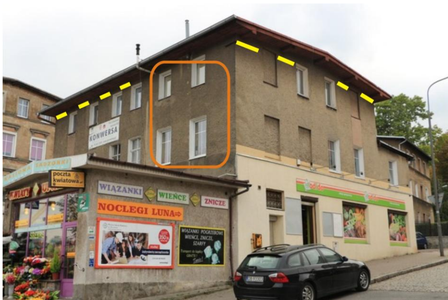
Ryc. 27. Budynek przy ul. Solickiej 2 – ściana wschodnia i północna - z zaznaczeniem miejsc realizacji kompensacji. Żółta linia oznacza 2 budki trocinobetonowe dla jerzyka (typ APK-2). Pomarańczowa linia – obszar wyłączony spod zawieszania budek dla jerzyków ze względu na zbyt bliską odległość do dachu sklepu na dole.
