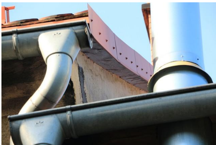
Ryc. 8. Budynek przy ul. Równoległej 11 – odnowione miejsce łączenia muru i dachu na ścianie szczytowej północnej.
