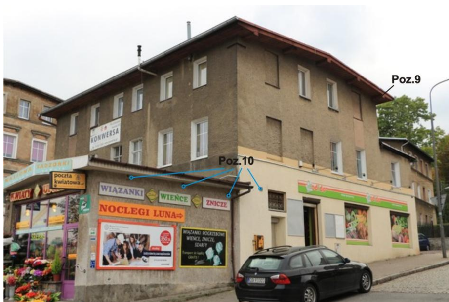
Ryc. 14. Budynek przy ul. Solickiej 2 – ściana północna i wschodnia - z zaznaczeniem pozycji stwierdzonych gniazd i siedlisk.
