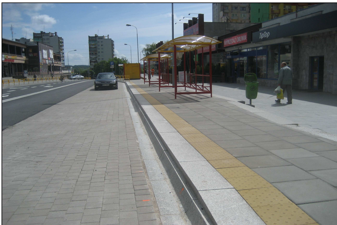
Rys. VIII.20. Podwyższony peron przystankowy – przykład realizacji z Wałbrzycha (Źródło: materiały własne).
