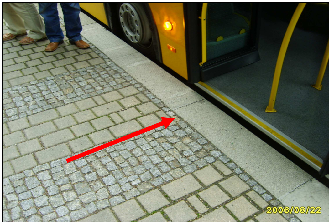
Rys. VIII.18. Strefa wejściowa – inny rodzaj nawierzchni jako ułatwienie dla osób niedowidzących i niewidomych naprzeciwko pierwszych drzwi autobusu (Źródło: materiały własne).
